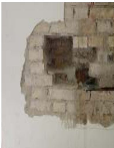
Stazione prelievo malta e laterizio
