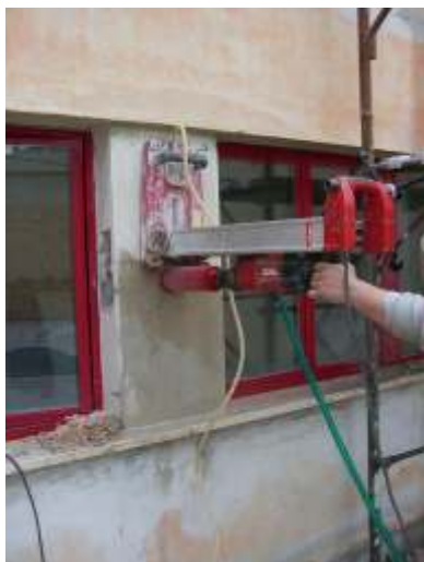
Carotaggio in Pilastro PP7
