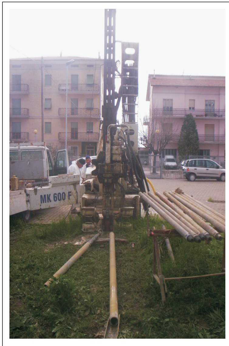
Postazione Sondaggio S1 Cantiere: Scuola Materna Via Giotto loc. Trodica nel Comune di Morrovalle (MC)
