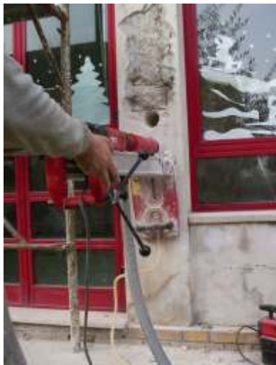
Carotaggio in Pilastro PT15
